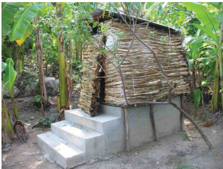
Exemple de latrine cuve avec parois en feuilles de bananiers (Saint Louis du Nord, zone de Rivière Salée)
